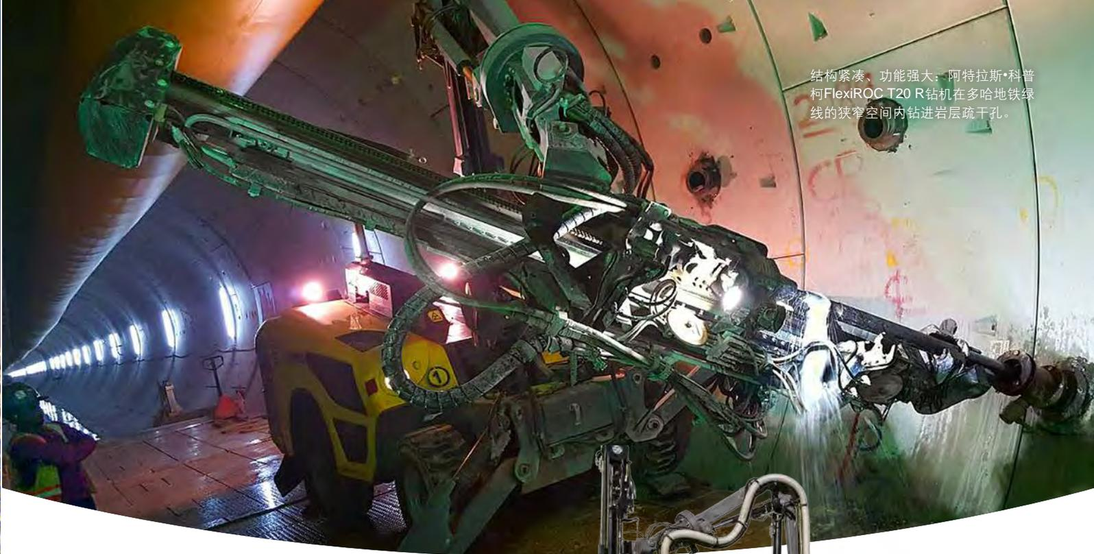
在卡塔尔首都多哈市超级地铁项目的建设过程中，施工人员正在采用露天凿岩设备解决常见的地下涌水难题。
